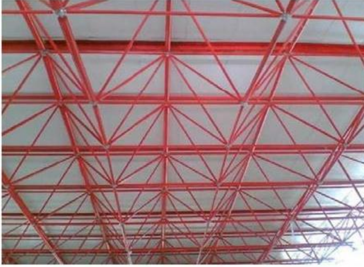
Şekil 5: Uzay Kafes Sistem Çatı Örneği
