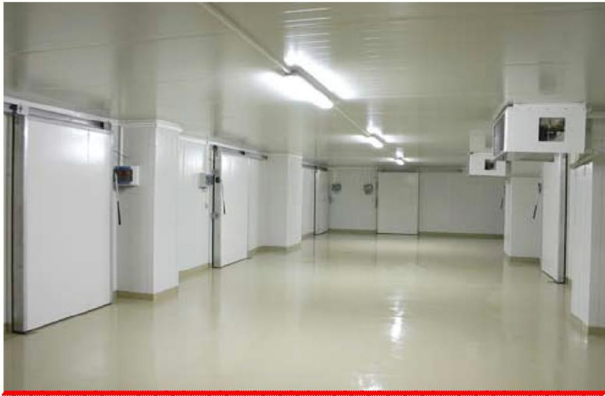
Şekil 1: Soğuk Hava Deposu Zemin Kaplama
